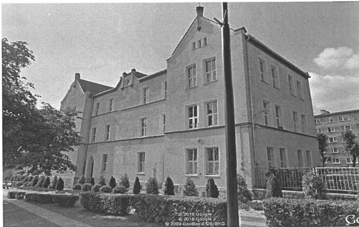
Fot.1 Zdjęcie elewacji frontowej
